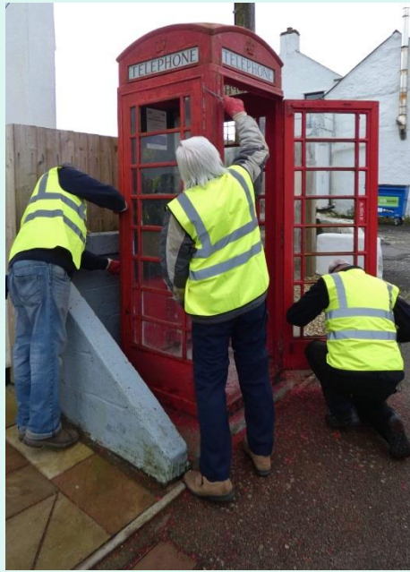
K6 Kiosk Repairs
